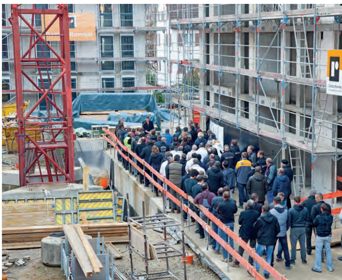
Blick auf den Rohbau, der Erstbezug ist für die zweite Jahreshälfte 2017 geplant.
